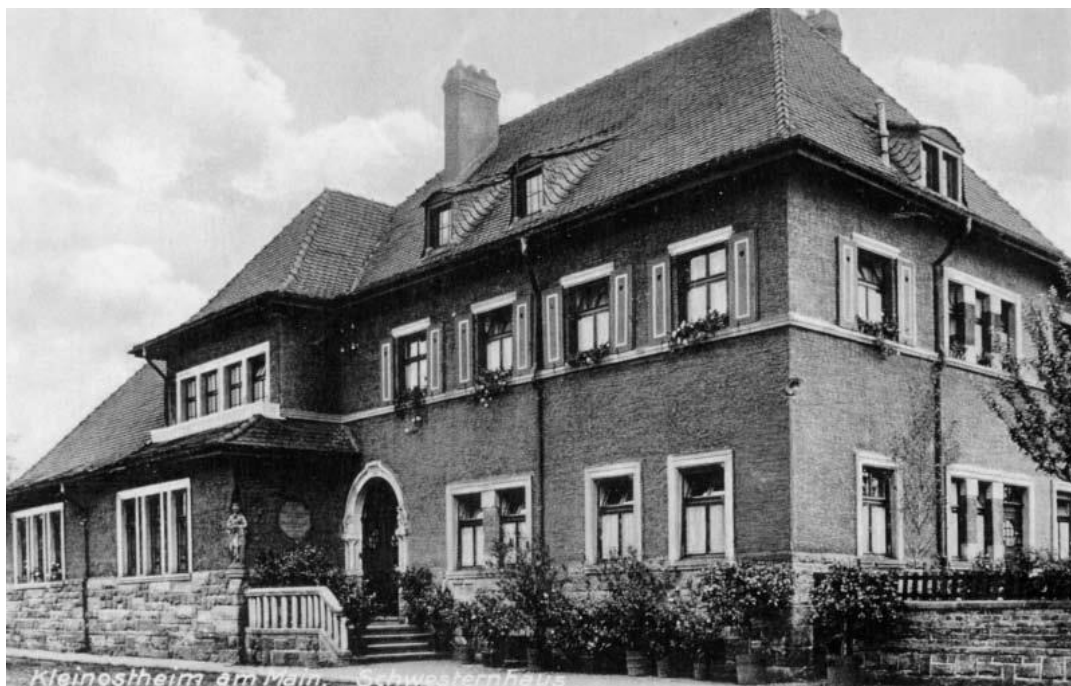
Abb. 8: Schwesternhaus und Kinderbewahranstalt, erbaut von dem Aschaffener Architekten Franz Schmitt Anno Domini 1913
