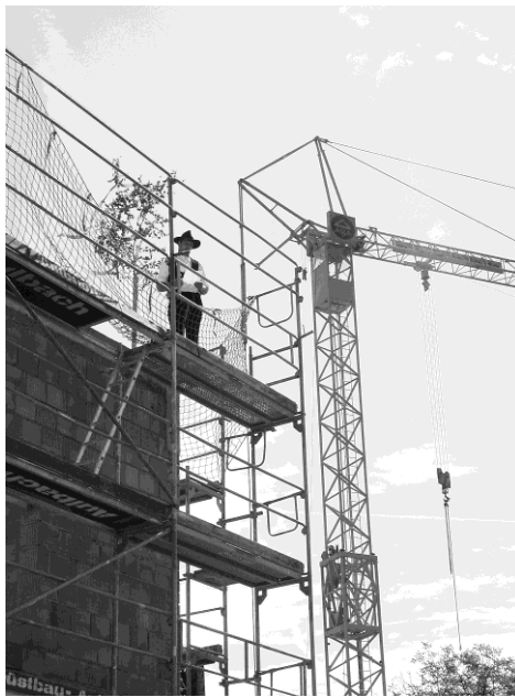
Abb. 80: Richtspruch durch den Zimmermann
