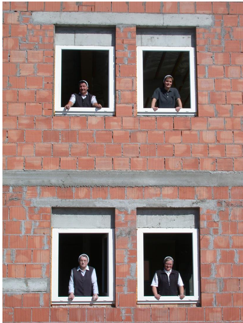
Abb. 81: Freudige Gesichter der Schwestern bei der „Besitzergreifung“ des Rohbaues unten: Oberin Martina, Sr. Marianne, oben: Sr. Hilga, Sr. Isabel
